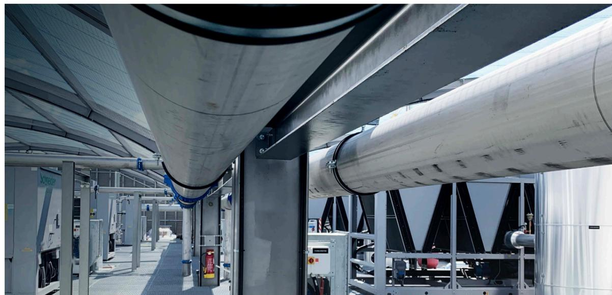
Photo du réseau de canalisation déployé pour le système de refroidissement « River Cooling »
